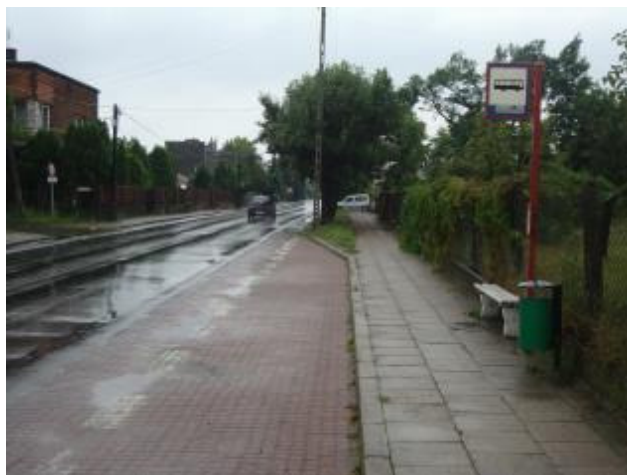
Rys. 5.10 Przystanek autobusowy z zatoką autobusową z kostki brukowej na ul. Szczęśliwej.
