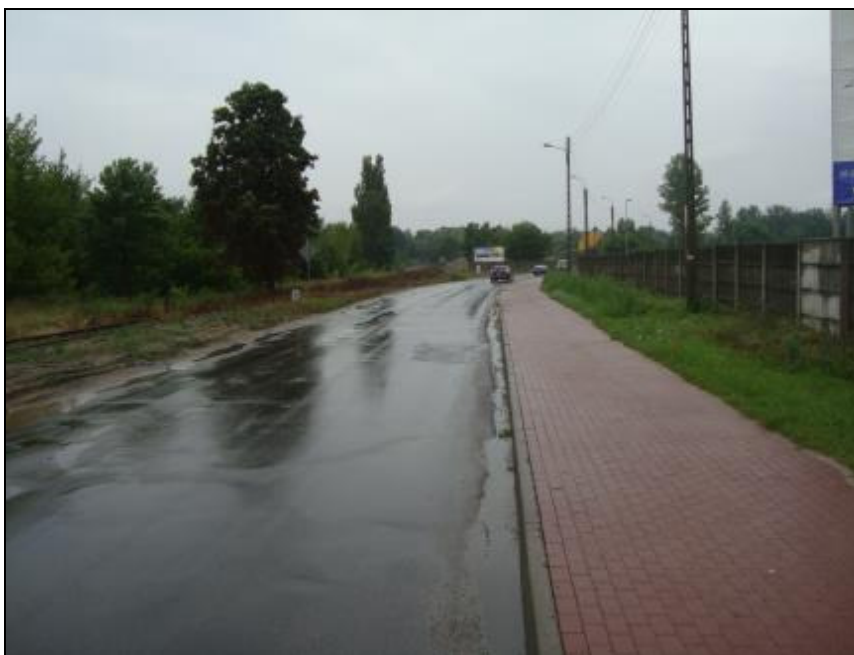
Rys. 5.20 Ciąg pieszo-rowerowy przy ul. Spalskiej.
