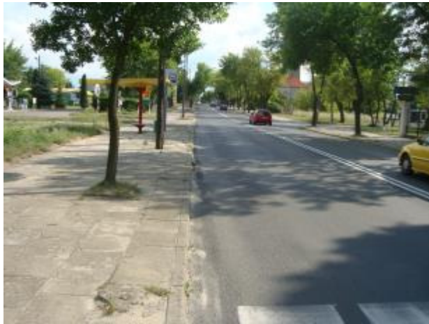
Rys. 5.7 Przystanek autobusowy przy krawędzi jezdni na ul. Warszawskiej.
