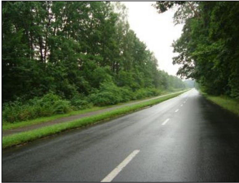
Rys. 5.13 Samodzielna ścieżka rowerowa oddzielona pasem zieleni przy ul. Jana Pawła II.
