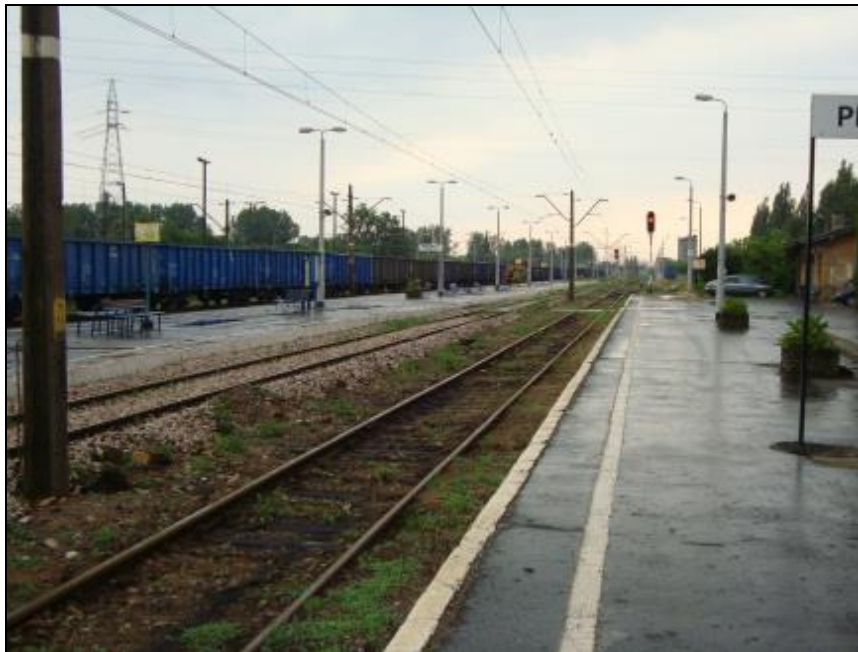
Rys. 5.29 Perony kolejowe stacji Tomaszów Mazowiecki.
