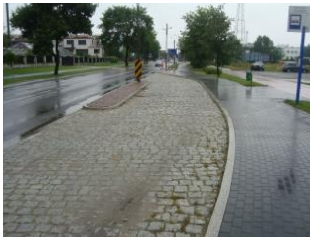
Rys. 5.9 Przystanek autobusowy z zatoką autobusową z kostki kamiennej na ul. Jana Pawła II.
