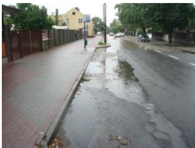
Rys. 5.11 Przystanek autobusowy z zatoką autobusową wykonaną z kostki betonowej trylinki, na której ułożono nakładkę asfaltową na ul. Spalskiej.
